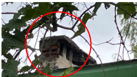
разрушенный оголовок дымовых и вентиляционных каналов
