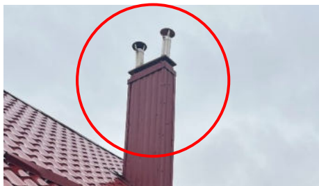
установка зонтов на дымовых каналах
